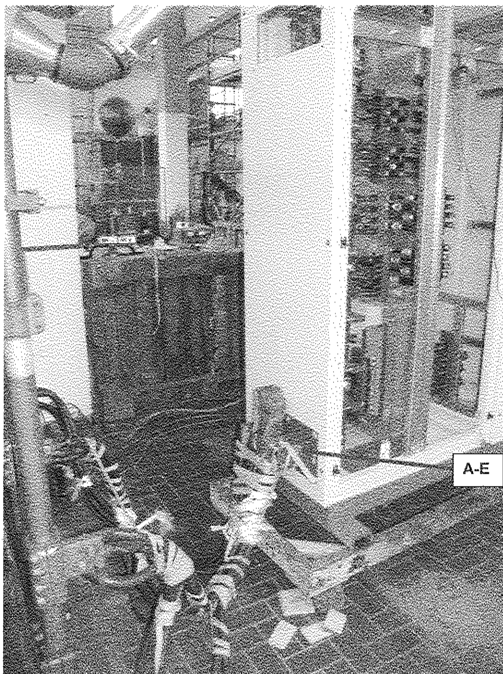
F.4 Vista connessione di alimentazione trifase.
