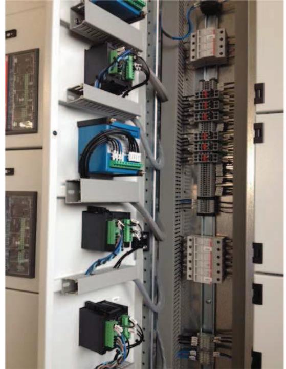
Particolare della canale alloggiamento circuiti e apparecchiature ausiliarie
