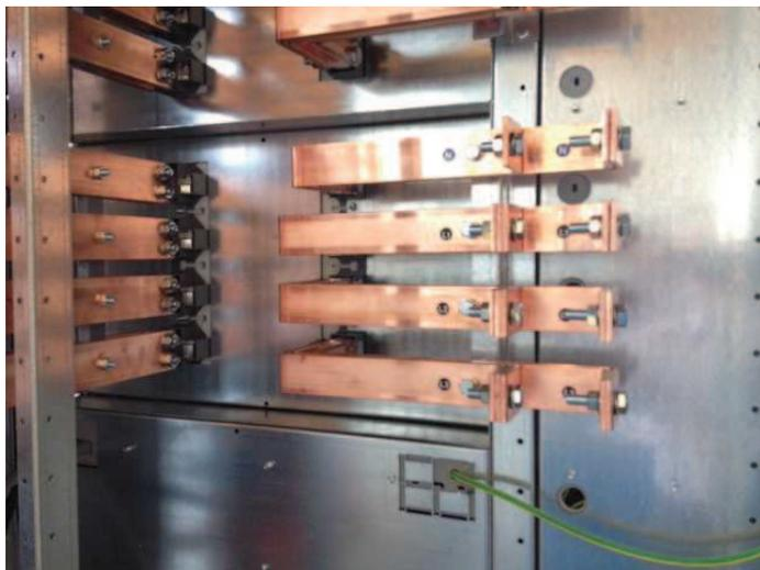
Particolare della parte posteriore del cubicolo di contenimento dei terminali posteriori di un interruttore scatolato.
