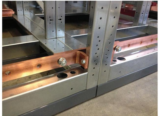
Particolare della sbarra di terra, con collegamento alla struttura e piastra di giunzione tra l'unità di trasporto.
