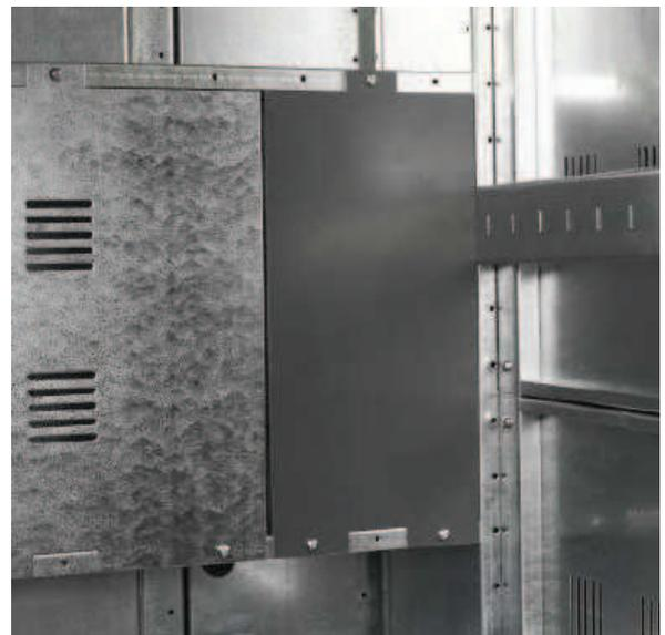
Nella foto sono ben visibili a destra le segregazioni delle barrature principali con in primo piano i traversini di ammarco dei cavi in entrata.
