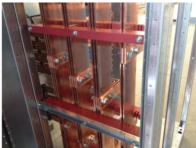
I portasbarre di ammasso del condotto sbarra sono realizzati in resina e vengono prodotti su nostro disegno.
